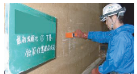
鉄筋位置探査状況
