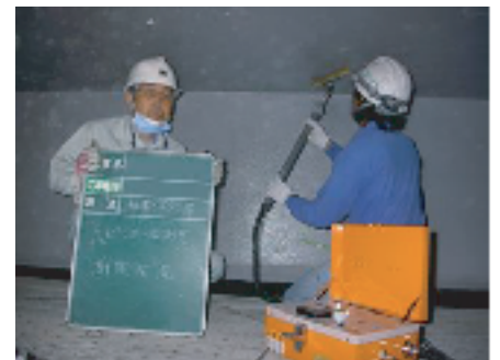
NCY施工後ピンホール検査状況
