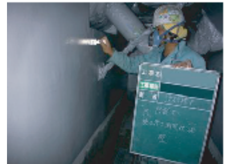
ウェットシクネスゲージによる塗膜厚測定状況
