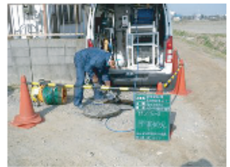
下水道TVカメラ調査作業状況
